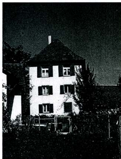
Ansicht des turmartigen Wohnhauses v. Westen. Foto: H. Wagner, 2002.
